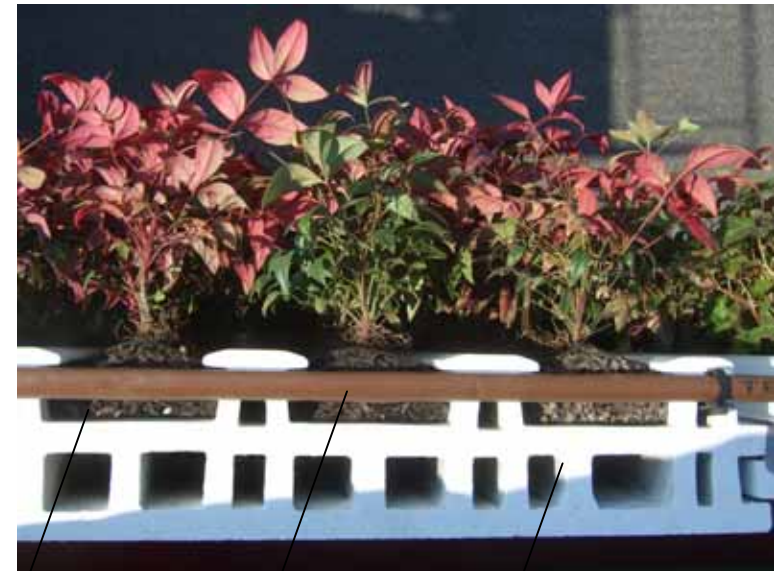
壁面緑化システム縦張り構成写真
