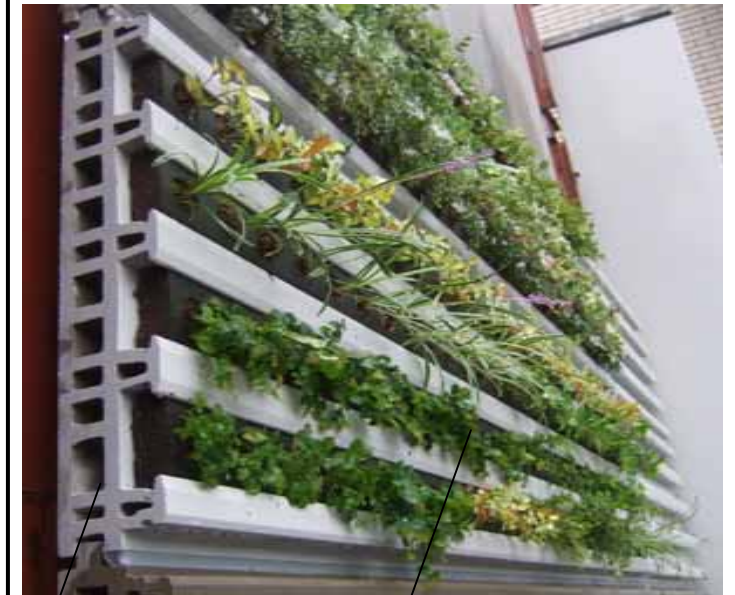
壁面緑化システム横張り構成写真
